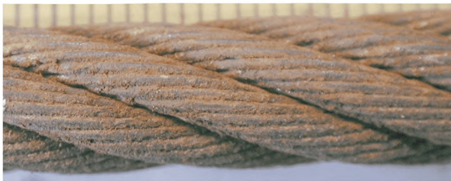
Рисунок Ж.2 — Поверхность проволочек шероховатая, коррозия распределена равномерно по длине каната. Степень повреждения — 20 %
